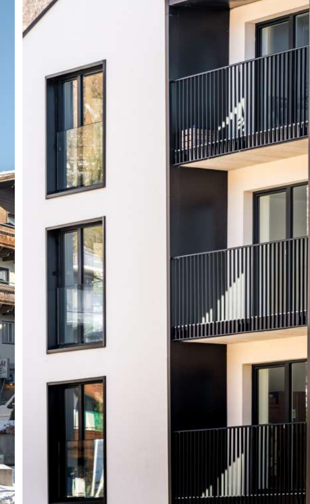
Die neuen Balkone mit verblechten Seitenwänden.
