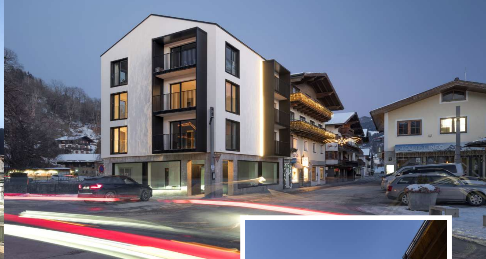
Zentrale Lage an der Salzachbrücke in unmittelbarer Nähe zur Kirche.
