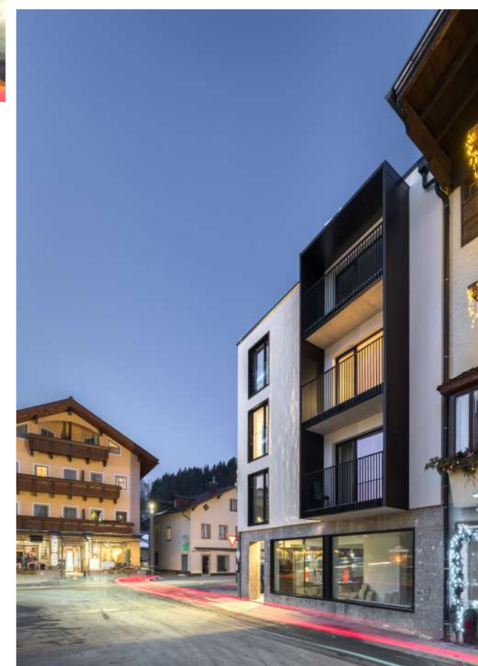
Das Haus bildet das Ende einer Gebäudezeile.
