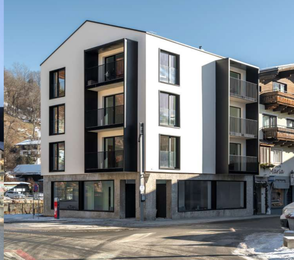
Unter Beibehaltung der Firstrichtung wurde auf ein Vordach verzichtet.
