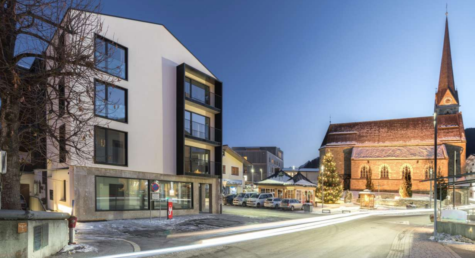
Saniertes und neugestaltetes Wohn- und Geschäftshaus im Ortszentrum von Bruck.
