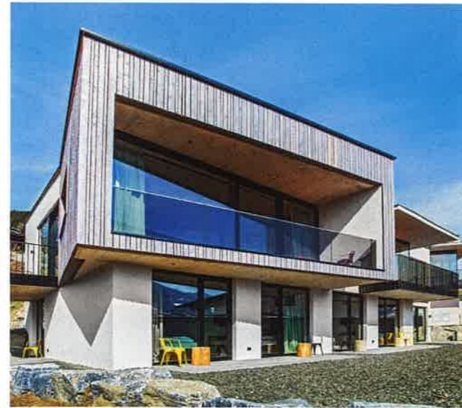
Die Gebäude wurden maßgeschneidert in die Hangböschung eingearbeitet, die Bereiche der Loggien mit einer Holzschalung verkleidet.
